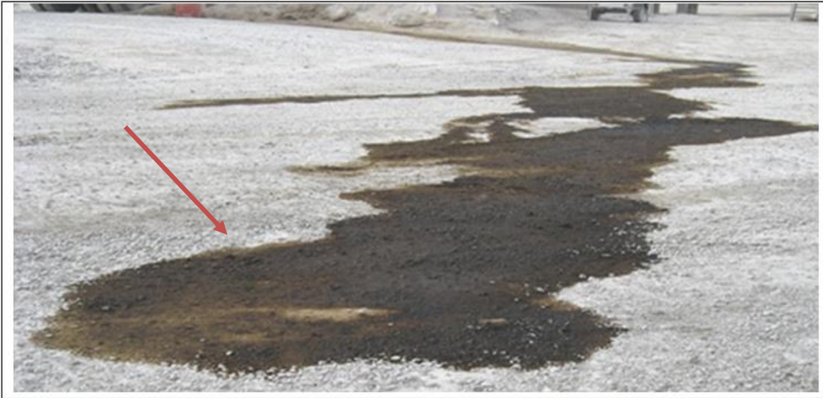
Figure n° (2) : Pollution du sol par les huiles, (Centre de béton).
