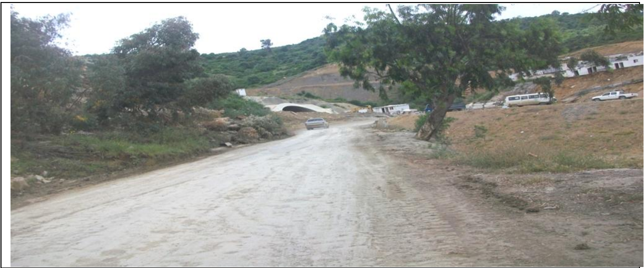
Figure n° (13) : La RN29 utilisée comme l'entrée et sortie des engins du chantier, risque d'accidentes (commune de Bouderbala).
