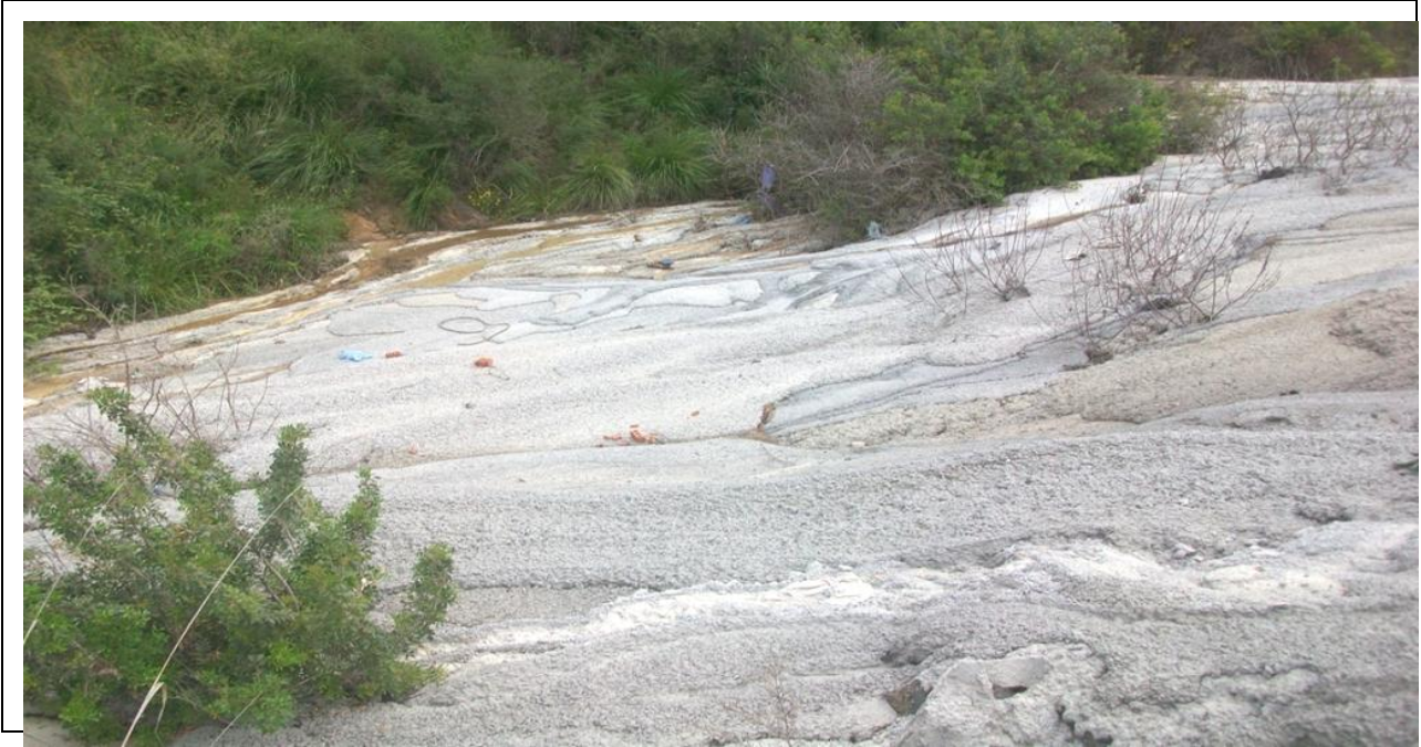
Figure n° (5) : Rejet de béton dans un cours d'eau liée par oued Bouzegza (centre de béton, entrée Tunnel T2).
